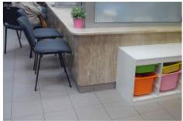
Lada w sali dla interesantów o wysokości umożliwiającej korzystanie z niej osobom na wózkach i osobom w pozycji siedzącej
