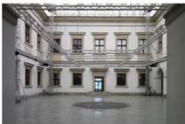
Dostępna strefa atrium, możliwość dowolnego kształtowania przestrzeni
