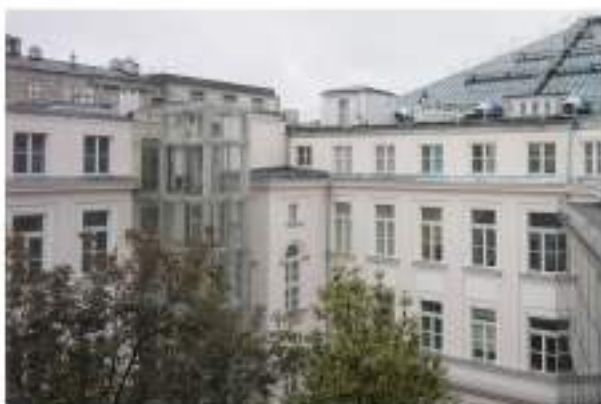
Zastosowanie zewnętrznej windy, która nie zmienia układu wewnętrznego budynku
