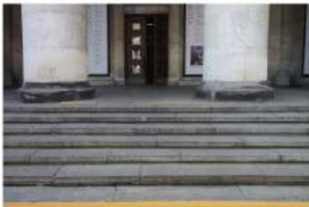
Wyraźne, kontrastujące linie oznaczające początek oraz koniec schodów
