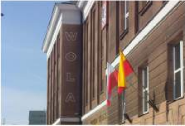
Neon na fasadzie głównej wspomagający identyfikację obiektu
