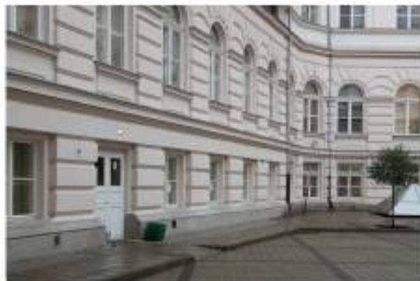
Pochylnia umożliwiająca znalezienie się na poziomie krawężnika
