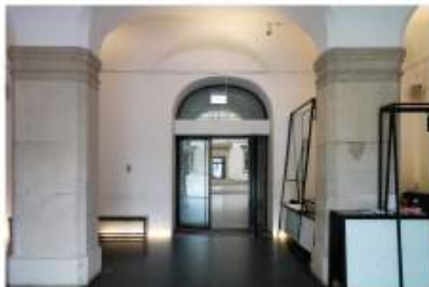
Brak progów. Posadzka chodnika, strefy wejściowej oraz atrium na jednym poziomie. Odpowiednia wysokość lady informacji
