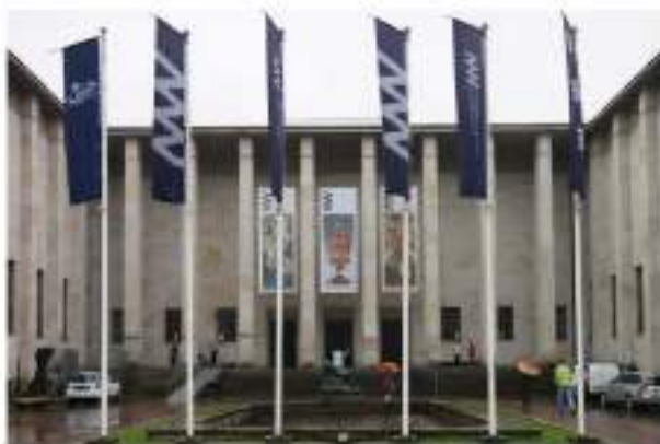
Zastosowanie podnośnika oraz pochylni, której konstrukcja nie niszczy schodów zabytkowego budynku. Drzwi wejściowe automatyczne, bez progów
