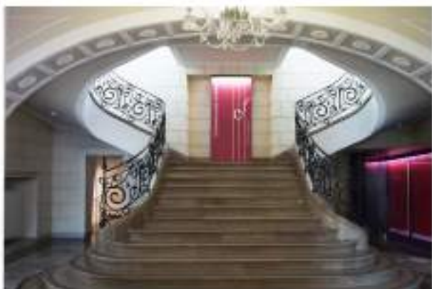
Stopnie schodów znaczone ciemnymi, kontrastującymi taśmami
